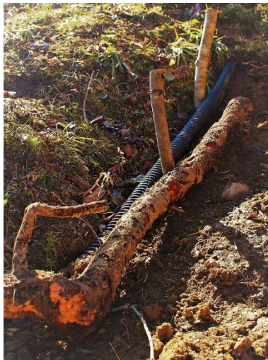
陥没した水路の整備補強、暗渠パイプの埋設の様子です。
