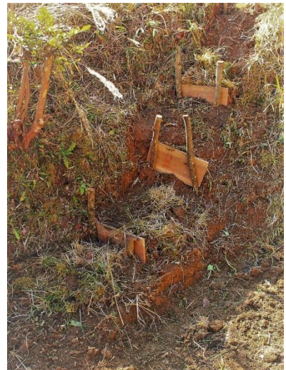
陥没した水路の整備補強、暗渠パイプの埋設の様子です。
